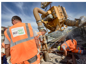
Die Sanierungsoffensive der U4 geht weiter. Foto: Wiener Linien/Zinner
